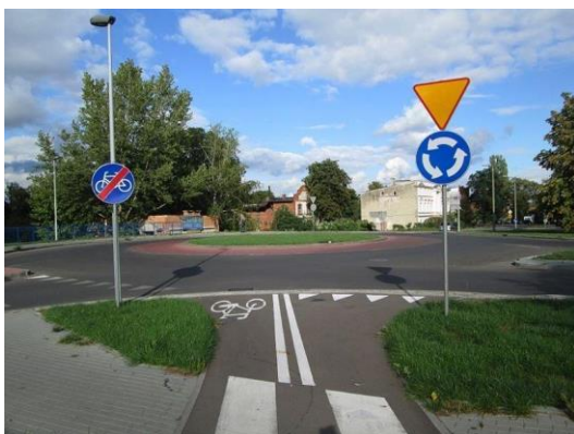
↑ Zdjęcie 4 – innowacyjne rozwiązania w zakresie infrastruktury rowerowej – droga dla rowerów jako samodzielny wlot skrzyżowania typu rondo
